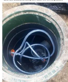
Csövek összekötése, diffúzorok elhelyezése
