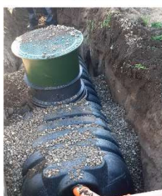
Rikutec 4000L tartály elhelyezése, sódertöltet
