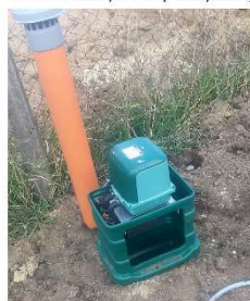
Elektromos vezeték, DUO kompresszor, huzatfej
